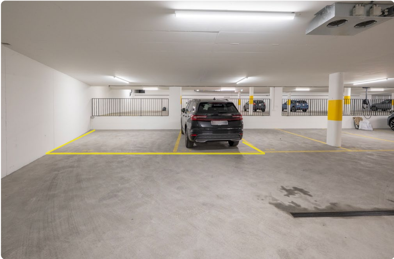
2 Tiefgaragenparkplätze B6 + B7
