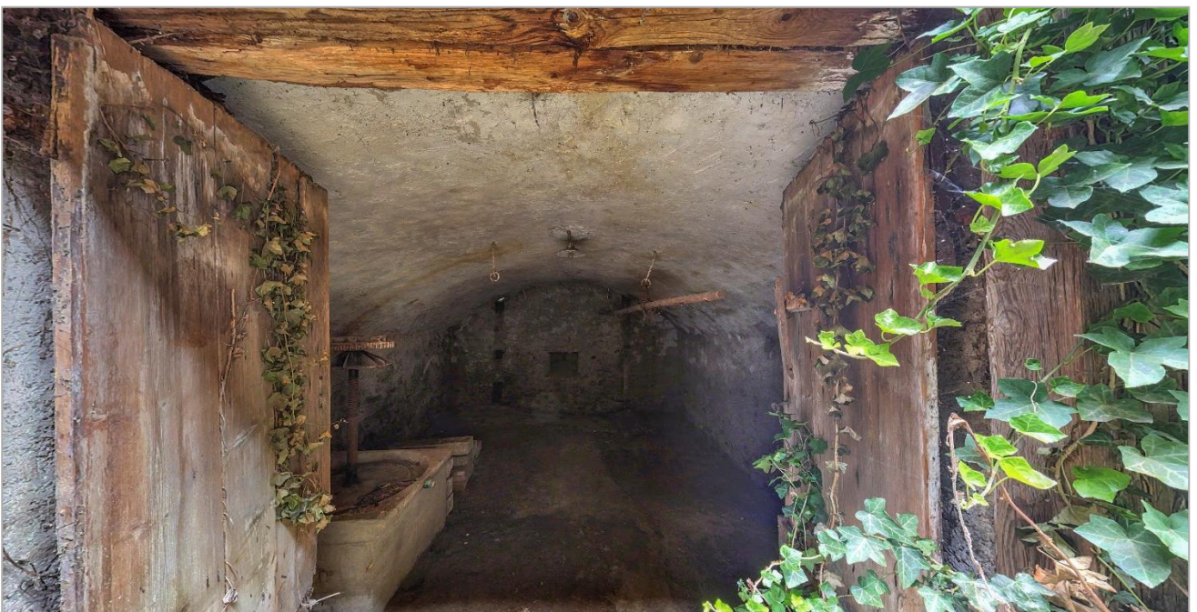
Blick in den alten Gewölbekeller
