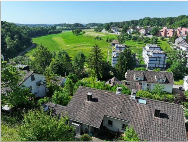
Blick Richtung Süden (Landstrasse)
