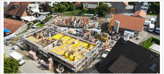
Baustelle Dozwil · Aufnahme 17.09.2026
