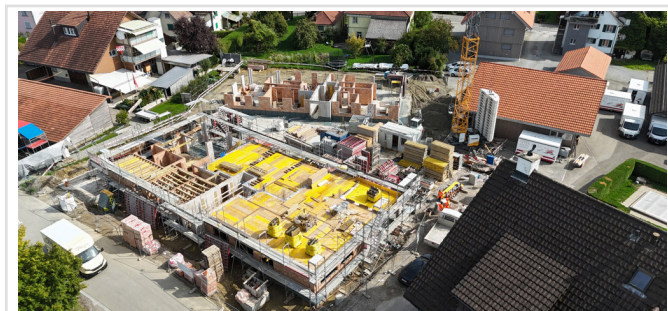
Baustelle Dozwil · Aufnahme 17.09.2026
